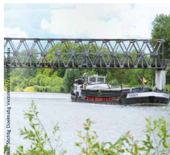
Rostfrei seit über 70 Jahren: stückverzinkte Ehzer-Brücke in Almen (NL)
